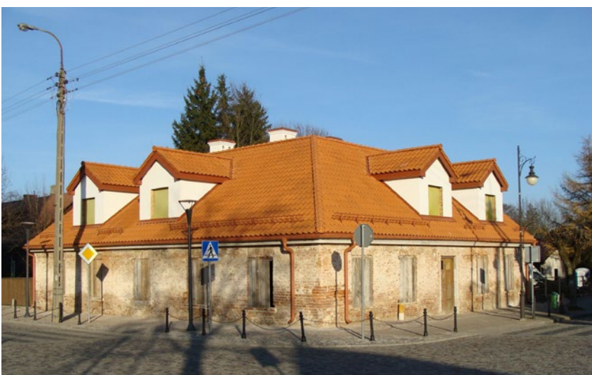
Stara Plebania przed i po remoncie [fot. UM Supraśl]
